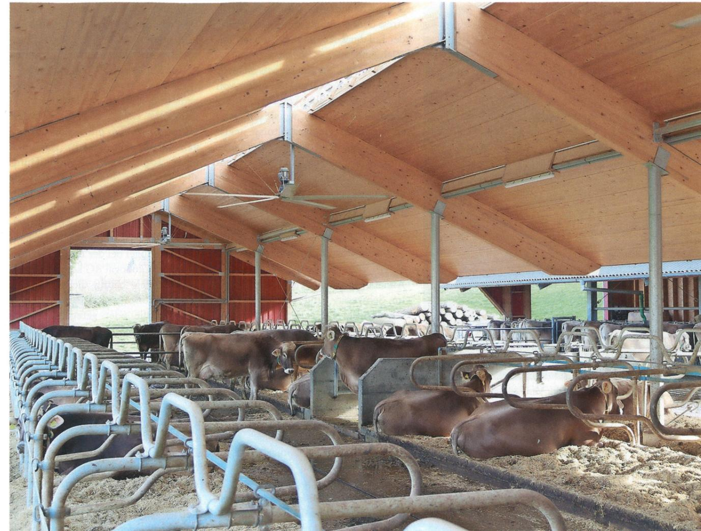
Mit Deckenventilatoren können grosse Flächen belüftet werden. Sie werden idealerweise in offenen Ställen mit wenig störenden Einrichtungen installiert.
