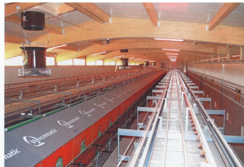
Werden im Geflügelbereich Unterdruck- und Gleichdrucklüftungen kombiniert, spricht man von einer Hybridlüftung.
