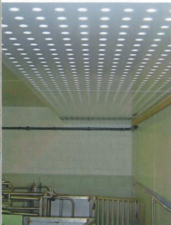
Ein Vorteil der Verdrängungslüftung (Lochdecken) ist, dass die Zuluft praktisch zugfrei in den Schweinestall geführt werden kann.
