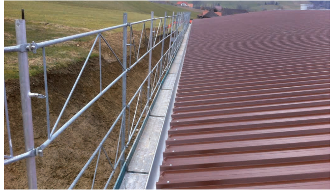
Revêtement de toiture
