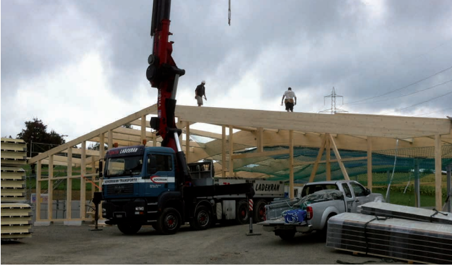
Construction du bâtiment
