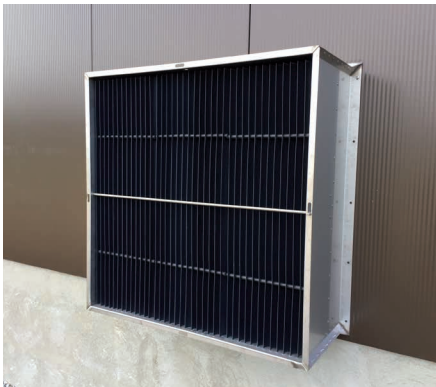
Éléments occultants pour ventilateur d'extraction
