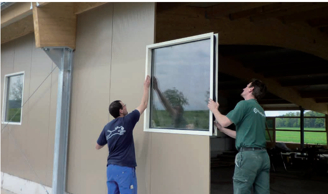
Montage des parois et des fenêtres
