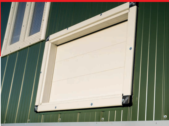
STARTER plus & STARTER max : Ouvertures de sortie automatisées
